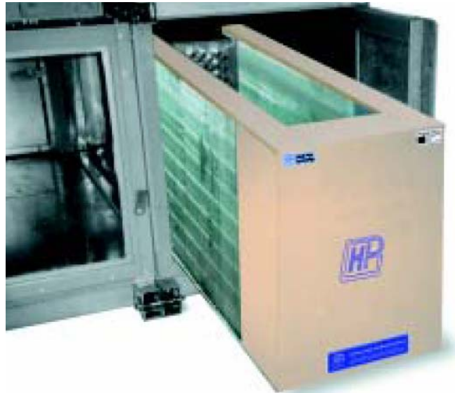
รูปที่ 4.1: แสดงการติดตั้งฮีทไปป์กับคอยล์เย็นของเครื่องเติมอากาศ (1)
