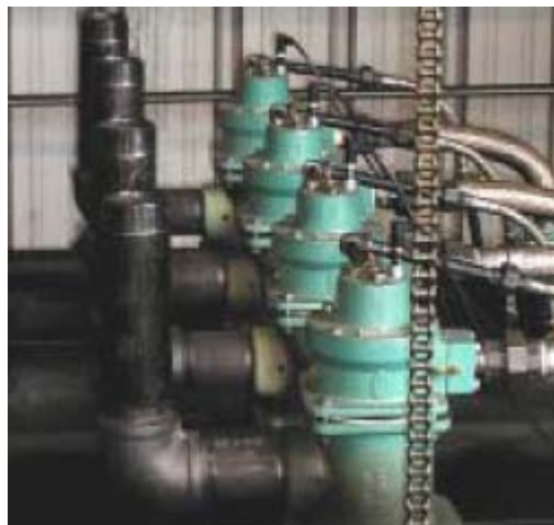
รูปที่ 4.1: แสดงการติดตั้งหัวเผาแบบเซลฟ์-รีคูเพอเรทีฟกับเตาเผา (3)
